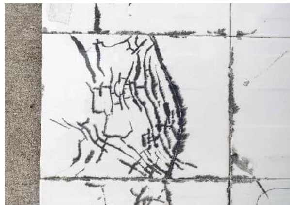
自然追痕案例收集——瓷砖上裂纹与颜色沁入
